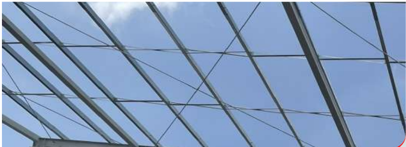
HỆ GIẪNG MÁI (GIẪNG ROD / CÁP / THANH GIẪNG XÀ GỖ) | 屋面支撐系統 (支撐桿 / 拉索 / 檁條支撐桿)
