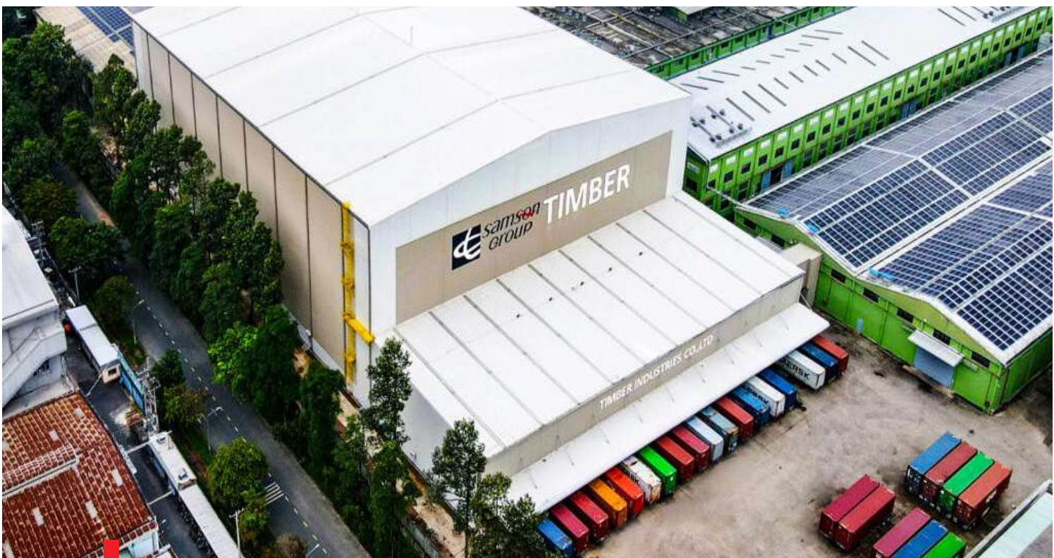
NHÀ KHO TỰ ĐỘNG CÔNG TY TNHH TIMBER TIMBER INDUSTRIES CO., LTD 自動倉庫
