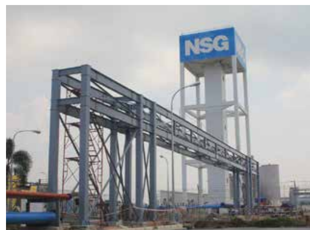
Nhà máy kính VGI3 - NSG Vietnam Glass Industry Factory VGI3 - NSG
