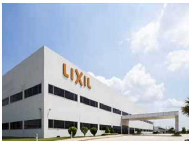
Nhà máy Lixil Lixil Factory
