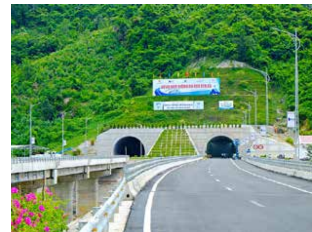
Hầm Đèo Cả Đèo Ca Tunnel
